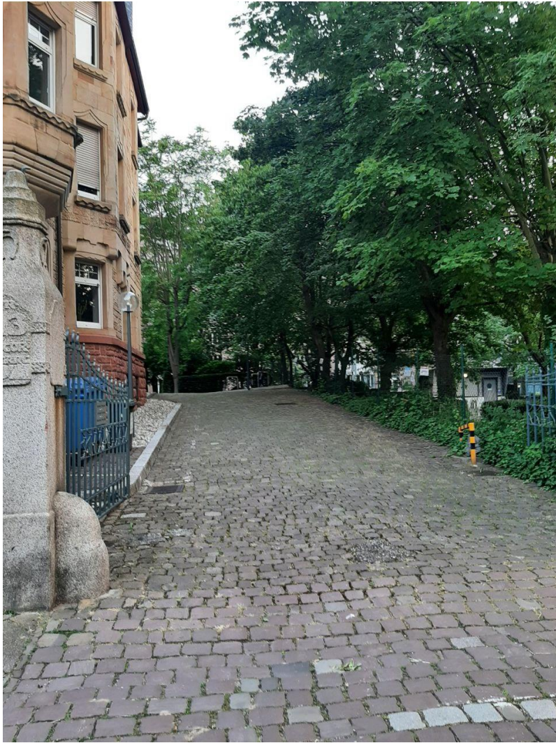
Einfahrt zu den Parkplätzen
